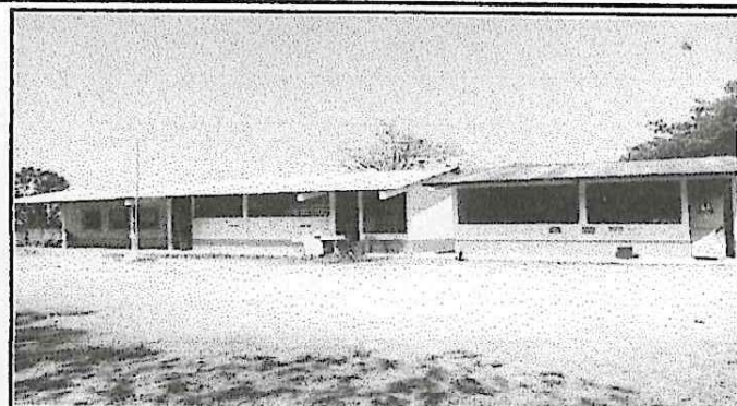
Foto 2: SUSTITUCIÓN DE LAMINA, POR LAMINA TROQUELADA, AULA 1 Y 2
