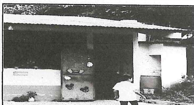
Foto 4: SUSTITUCIÓN DE PUERTAS, AULA 1, AULA 2, AULA 3 Y COCINA
